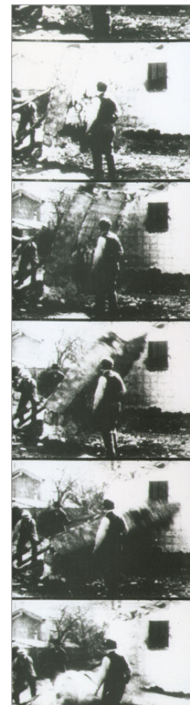
Demolition of a Wall, 1973 (Extrait de 3 minutes) Film 16mm transféré en vidéo digitale, n&b, sonore, durée 25 minutes © Photo Bill Brand, courtesy Galerie Arnaud Lefebvre
